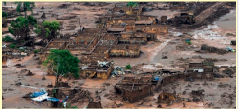
Bento Rodrigues após o rompimento da Barragem de Fundão
