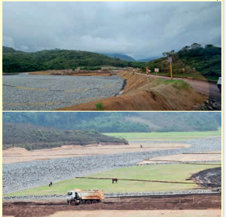
Registros da visita técnica da ATI em 13/11- O processo de descaracterização da barragem teve início em 2019 e está programado para ser concluído em 2029
