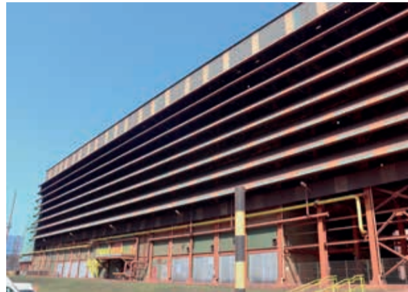
Usina da 4ª Pelotização
