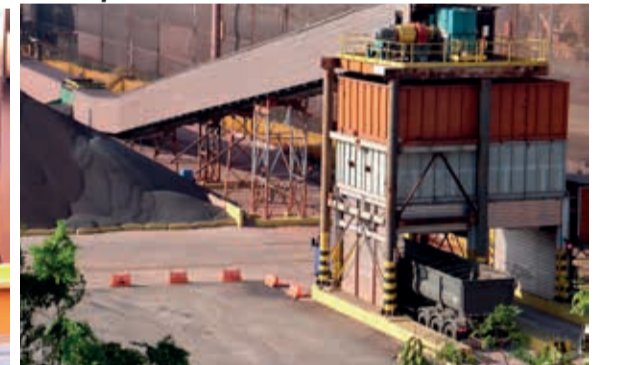
Área de carregamento de caminhões
