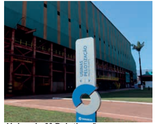
Usina da 3ª Pelotização
