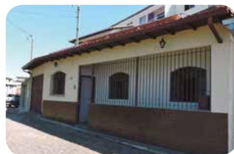
Fachada do imóvel antes da pintura e das adequações
